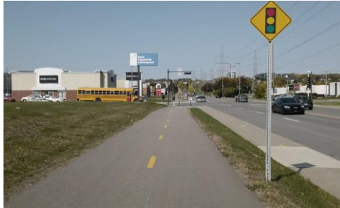
Piste cyclable bidirectionnelle Présence d'une banquette végétalisée Limite de vitesse à 50 km/h Réseau artériel
