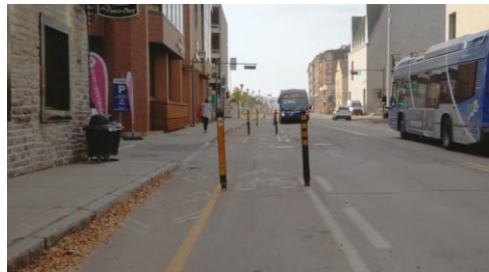
Bande cyclable bidirectionnelle Présence d'entrées de stationnement hors rue Réseau artériel Limite de vitesse à 50 km/h
